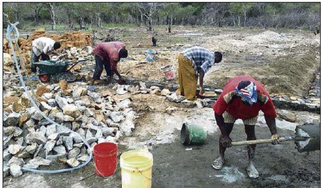
Alle helfen tatkräftig mit, die Schule in Mnazi im nordöstlichen Tansania zu errichten.
